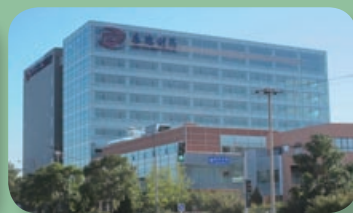
北京泰德廠房
